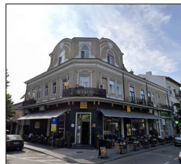
12. Imobil de locuit cu parter comercial
