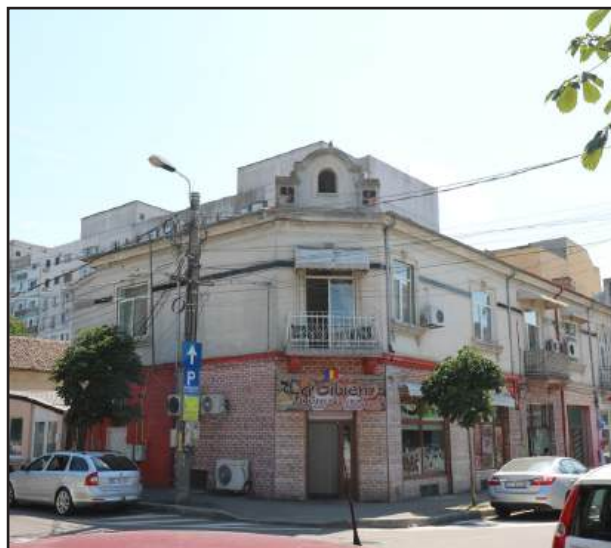
30. Imobil de locuit cu parter comercial
