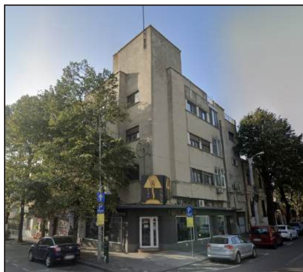
14. Imobil de locuit cu parter comercial
