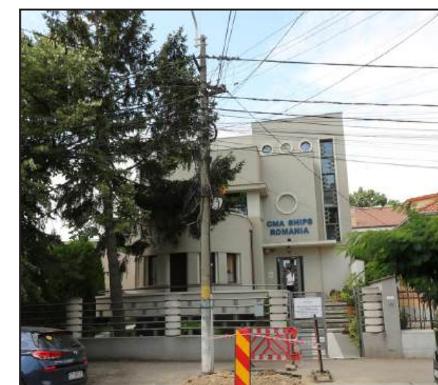
4. Imobil modernist - sediul unei firme
